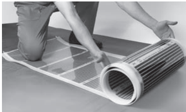
Рис. 3. Раскатывание рулона теплового пола на теплоотражающем материале
