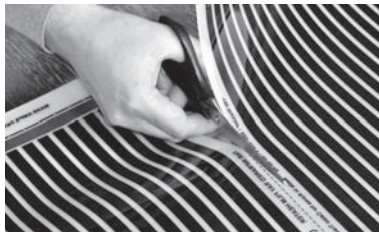
Рис. 4. Разрезание термопленки CALEO по линиям отреза
