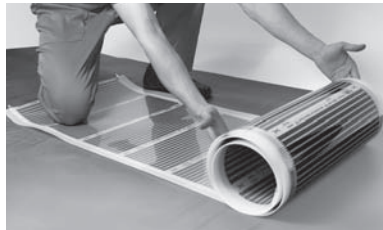
Рис. 3. Раскатывание рулона теплового пола на теплоотражающем материале
