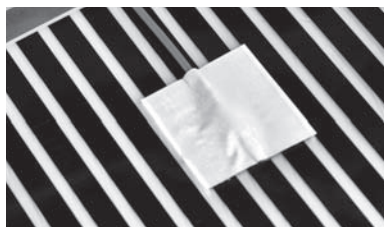
Рис. 17. Установленный и приклеенный датчик температуры пола. Вид снизу термопленки
