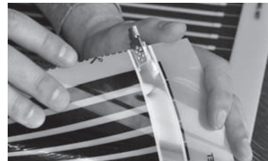
Рис. 5. Установленный на термопленку контактный зажим
