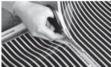
Рис. 4. Разрезание термопленки CALEO по линиям отреза
